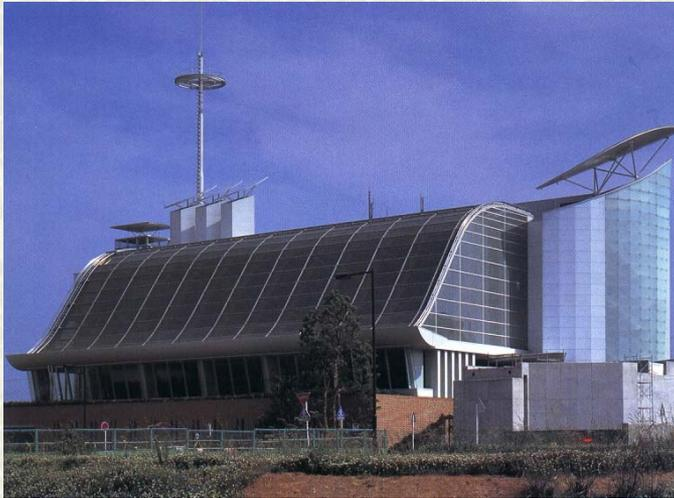
辦公區之天花板採傾斜設計，輕微的傾向辦公區中央，為使辦公區能有最大的採光量。大廳的玻璃由大曲面之薄板支撐，採用低放射率之玻璃。
