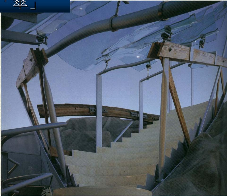
材料利用附近舊建材拆卸下來的桁架構成
