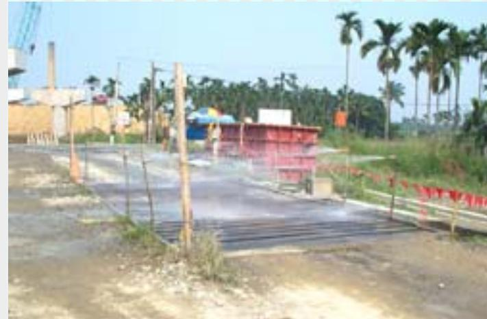
洗車台之設置可對進出車輛進行清洗工作俾減少土石溢散，洗車用水收集處理後並再利用
