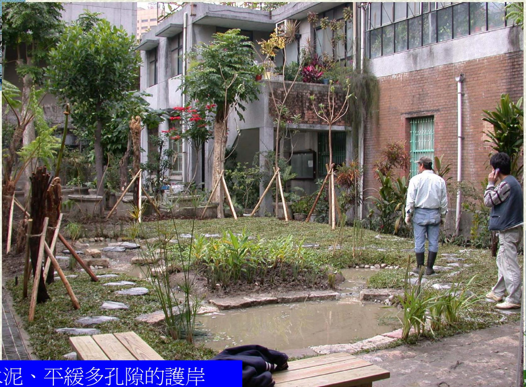
非水泥、平緩多孔隙的護岸
