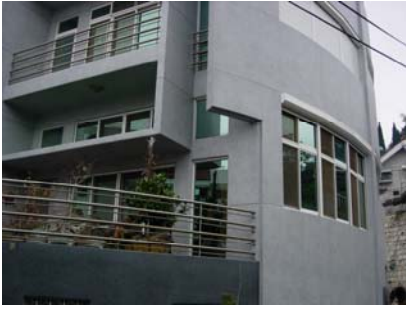
照片 3.5-翻新後正面
