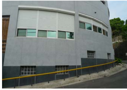
照片 3.6-翻新後側面
