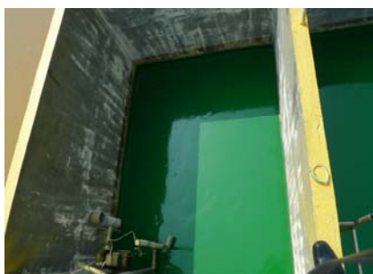
照片 3.0-翻新後屋頂層
