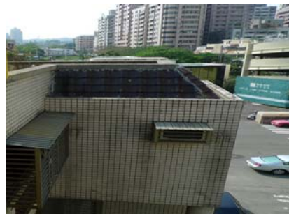
照片 2.8-翻新前壁體&瓦檐
