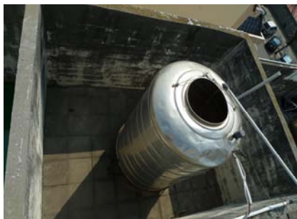
照片 2.8-翻新前屋頂層
