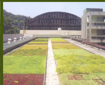
薄層式-吳興國小(你也能有綠屋頂) 財團法人台北獨環綠化基金會，2007)
