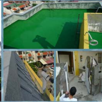
屋頂防水層&瓦檐&鐵門更新
