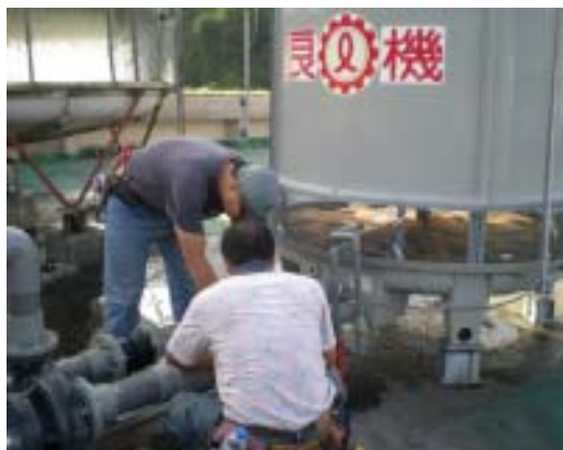
冷卻水塔效率改良
