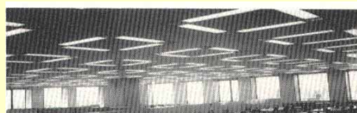
ルーバー付き照明器具
