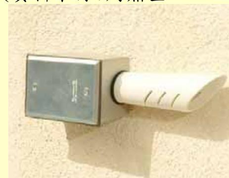
圖 室外溫度偵測器
